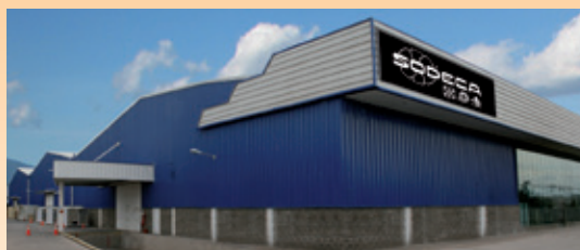
Instalaciones centrales de SODECA S.L.U. en Sant Quirze de Besora y planta de fabricación en Santiago de Chile.
